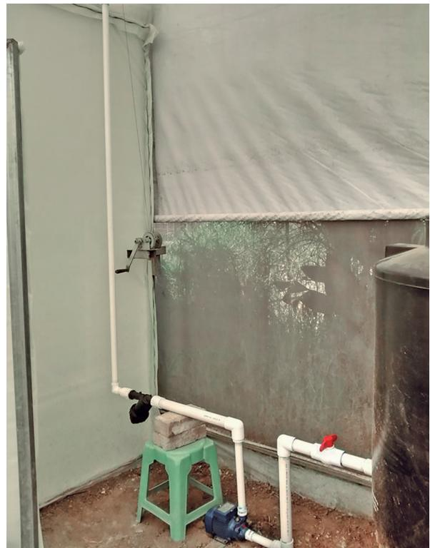
Imagen 15. Sistema de bomba para aspersores automáticos.
