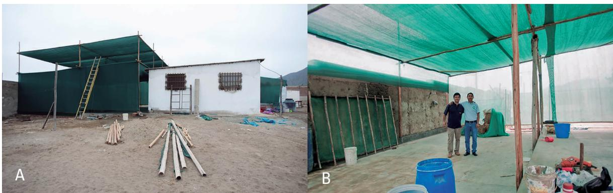
Imagen 18: Sala de producción hecha de material (a); sala de cultivo con estructura de madera, techos y paredes de media sombra (b).
