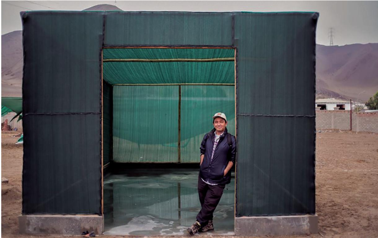
Imagen 19: Sala de cultivo con piso de material, estructura de madera (tacuaras), paredes y techos de media sombra.
