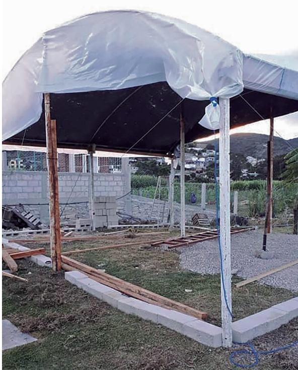
Imagen 23: Proceso de construcción de sala de cultivo. Estructura de madera y piso con una capa de piedra. Techo de media sombra y paredes de plástico.
