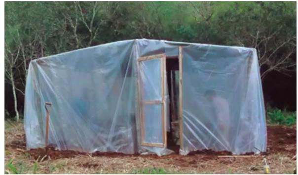
Imagen 21: Proceso de construcción de sala de cultivo. Estructura de troncos y bambú. Techo cubierto con media sombra y paredes de plástico.
